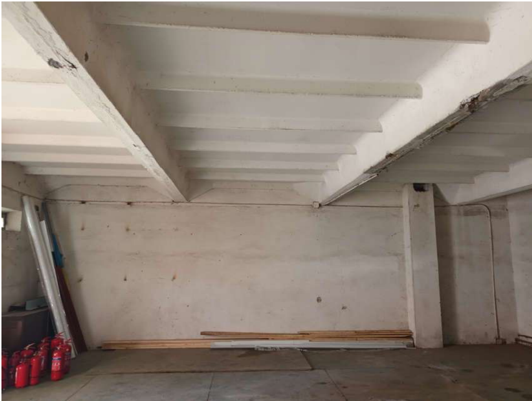
F-9 Ratinės pastato antro aukšto fragmentas su skersine siena, brianuotomis perdangos plokštėmis.
