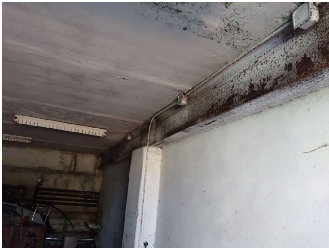
F-6 Ratinės pastato pirmo aukšto vidaus fragmentas su pertvara, mūro stulpu, laikančia plieno siją.
