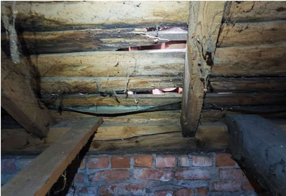
F-7 Pastato stogo laikančios konstrukcijos. Bendras vaizdas. Mūrtašis, gegnė, lentų paklotas.
