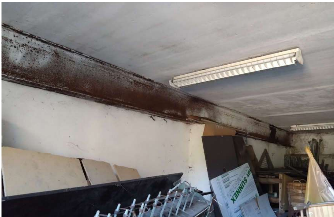
F-7 Ratinės pastato pirmo aukšto vidaus fragmentas su pertvara, mūro stulpu, laikančia plieno siją.
