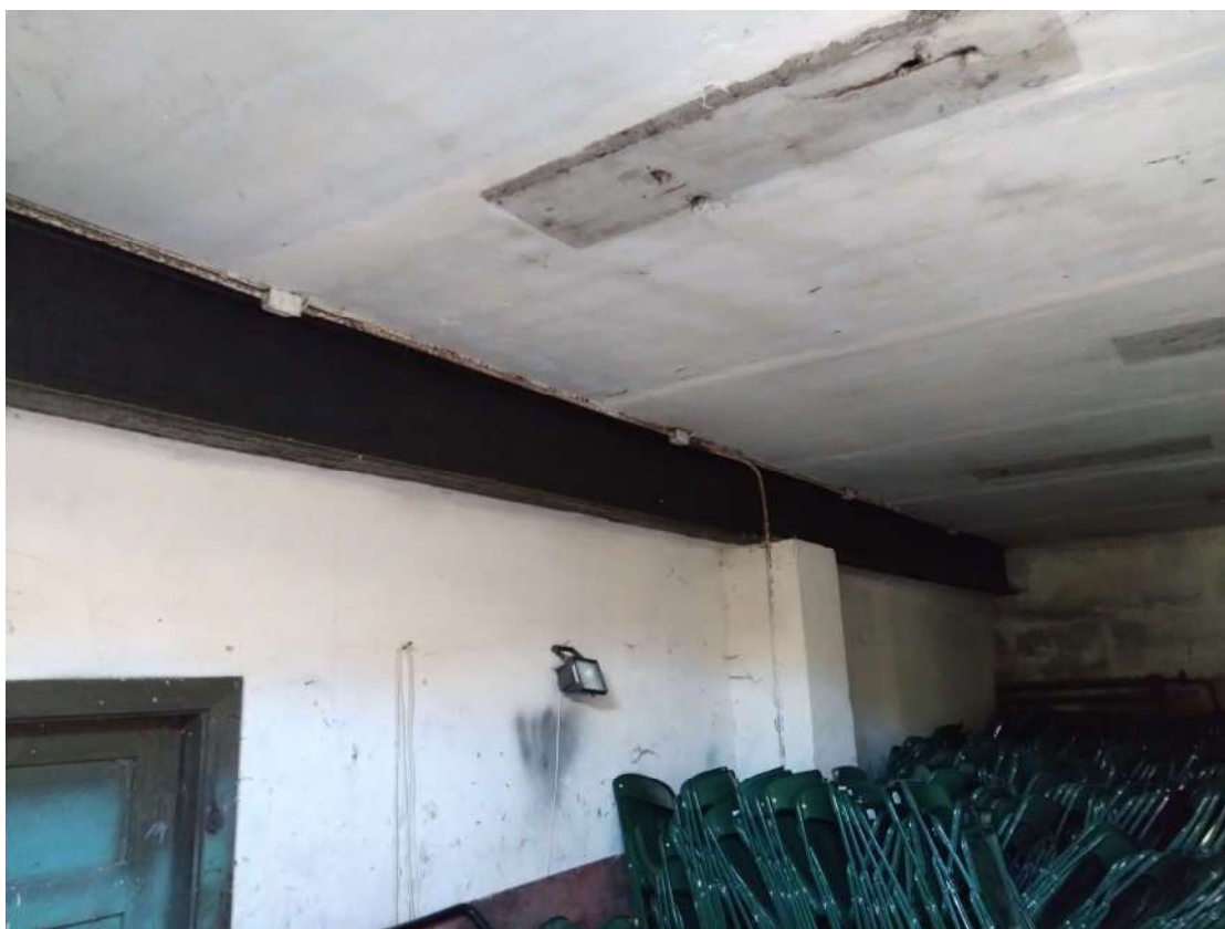
F-8 Ratinės pastato pirmo aukšto vidaus fragmentas su pertvara, mūro stulpu, laikančia plieno siją.
