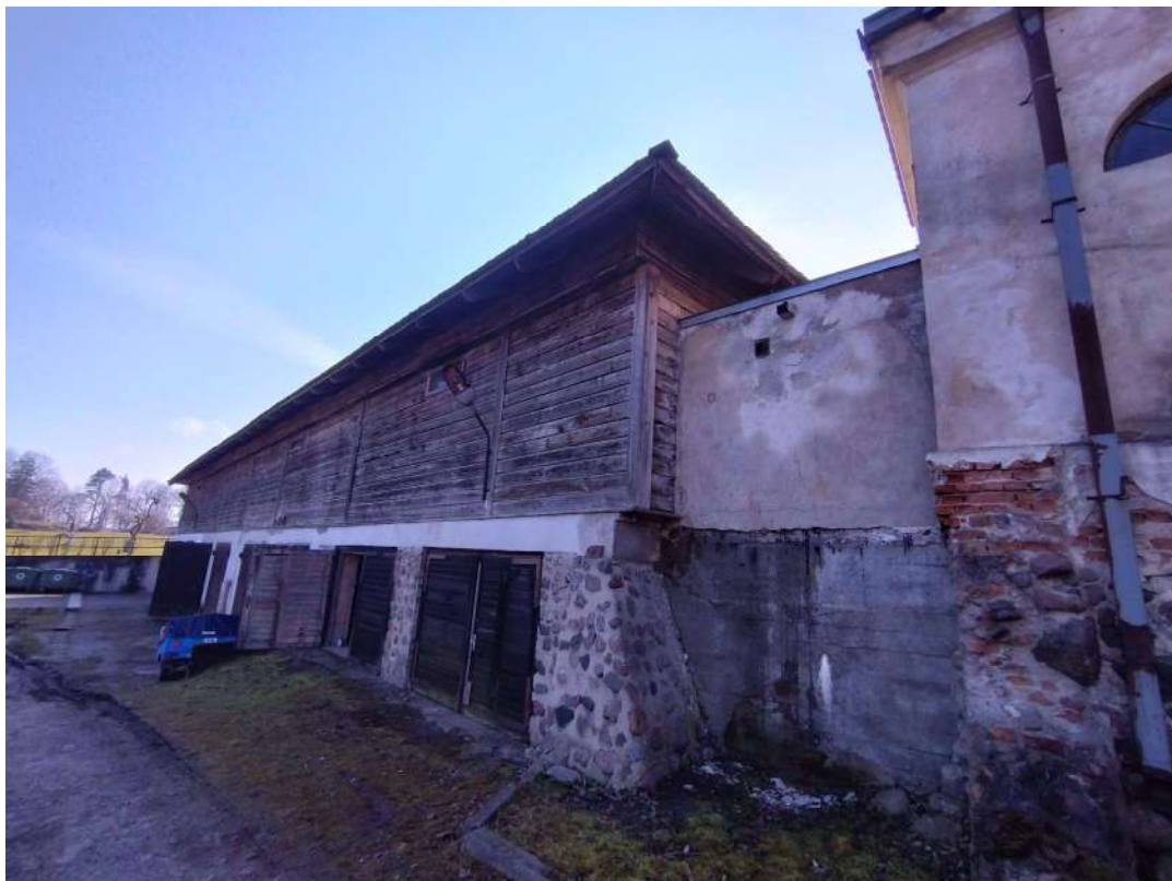
F-5 Ratinės pastato šiaurinio fasado fragmentas. Blokavimo su katiline vieta.
