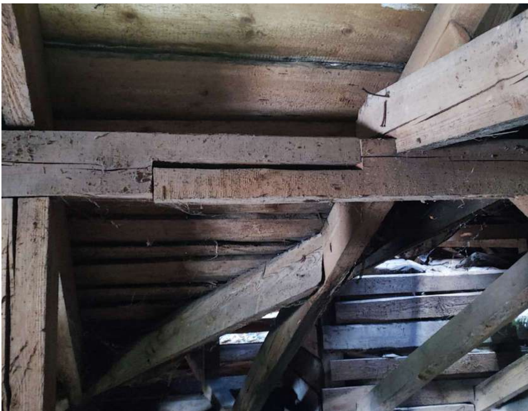
F-10 Pastato stogo konstrukcijos. Rėmo viršutinės sijos sandūra.
